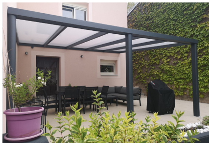
PREKRYTIA TERÁS PRI FASÁDE
